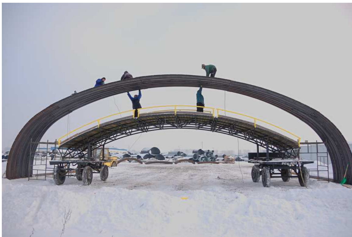
Rys. 1. Montaż konstrukcji stalowej SuperCor SC-57S.
