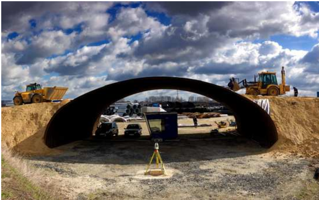
Rys. 5. Konstrukcja SuperCor SC-57S w trakcie budowania. Fig. 5. The SuperCor SC-57S structure during construction.
