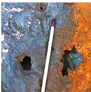
Rys.2. Przykłady perforacji w blachach podłogi analizowanego zbiornika Fig.2 Examples of the sheet perforation
