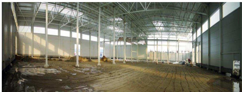
Rys. 3. Hala w końcowym etapie budowy
